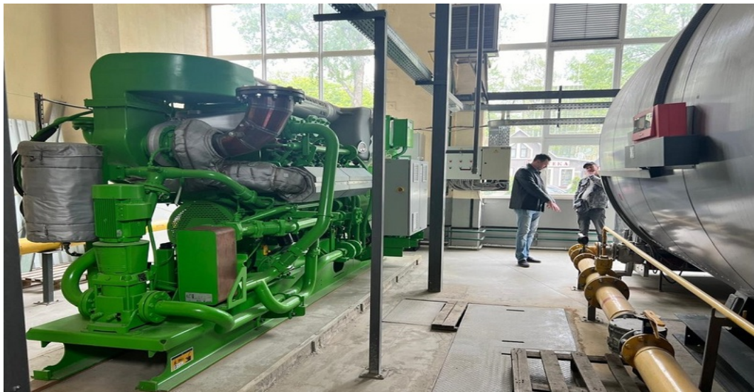
Рис 3.4. Монтаж електрогенеруючого обладнання
